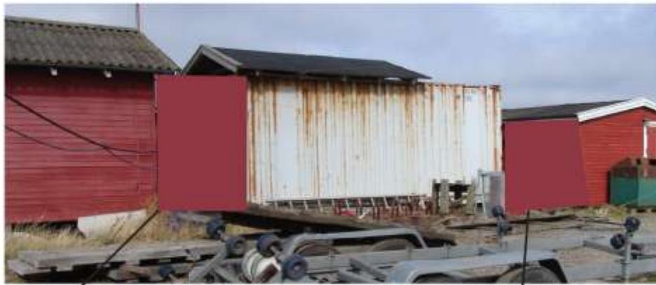
Afdækning fra jord til top af container
